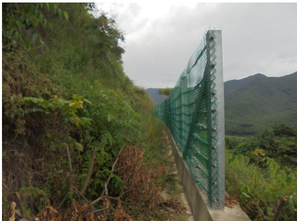
소단배수로, 낙석방지울타리 전경
