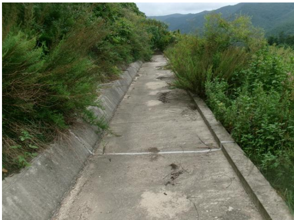
1소단 배수로 전경
