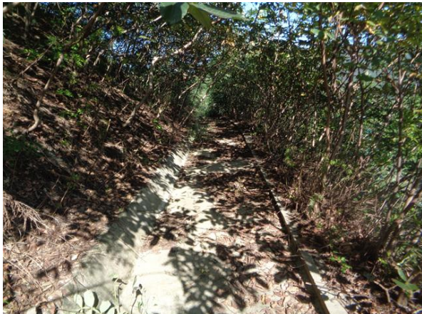
1소단 배수로 전경
