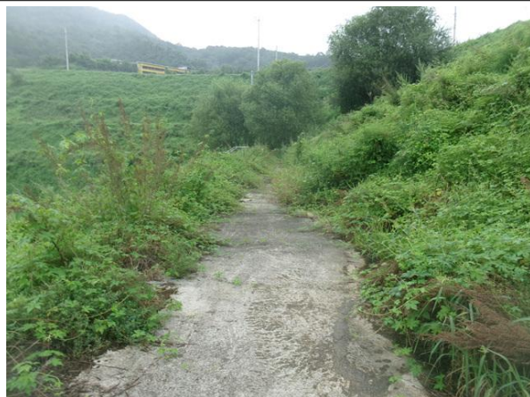
1소단 배수로 전경
