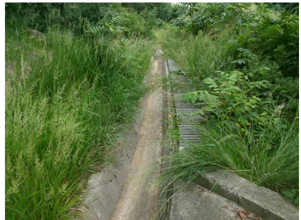
산마루측구, 점검계단 전경
