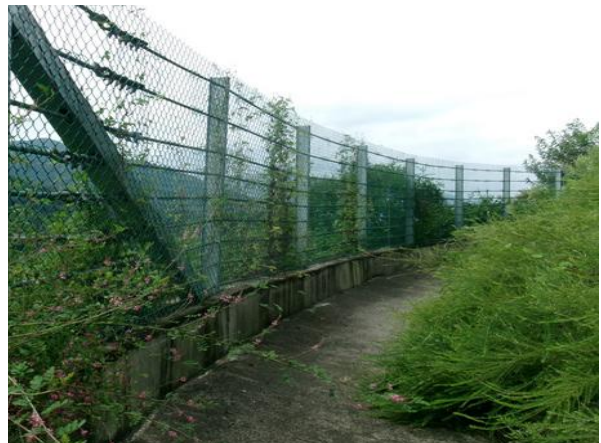
2소단 배수로 전경
