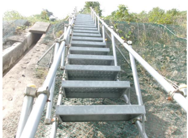
수직도수로, 점검계단 전경
