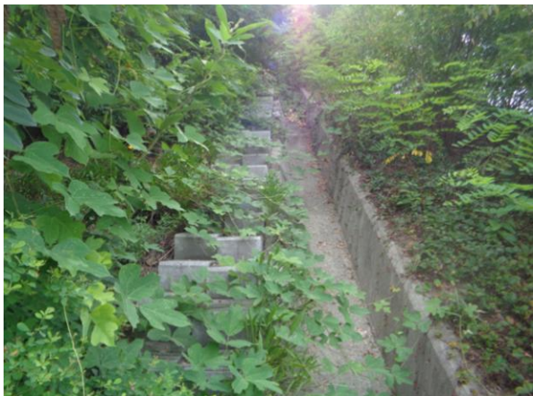
산마루측구, 점검계단 전경
