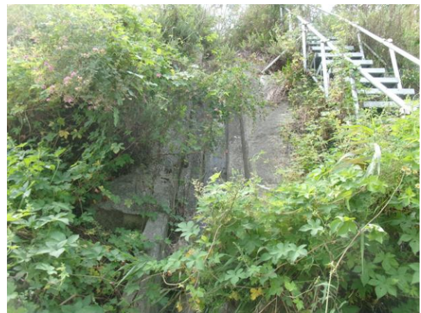
수직도수로, 점검계단 전경
