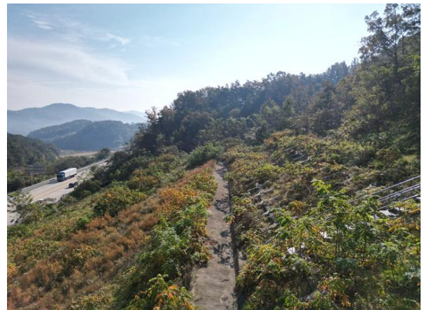
1소단 배수로 전경
