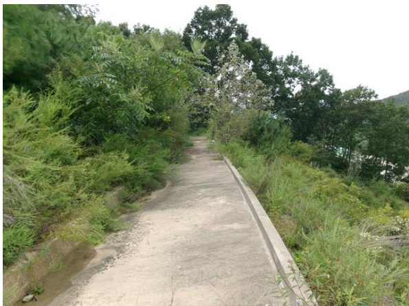
1소단 배수로 전경
