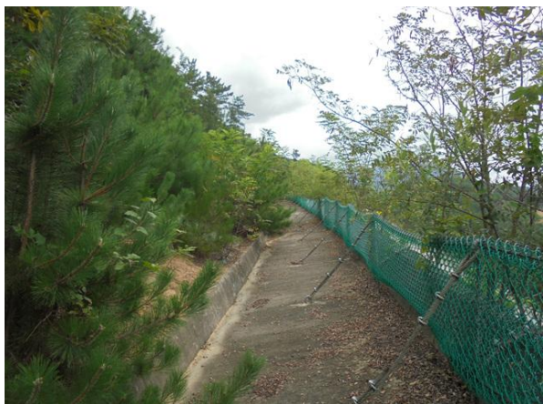
1소단 배수로 전경
