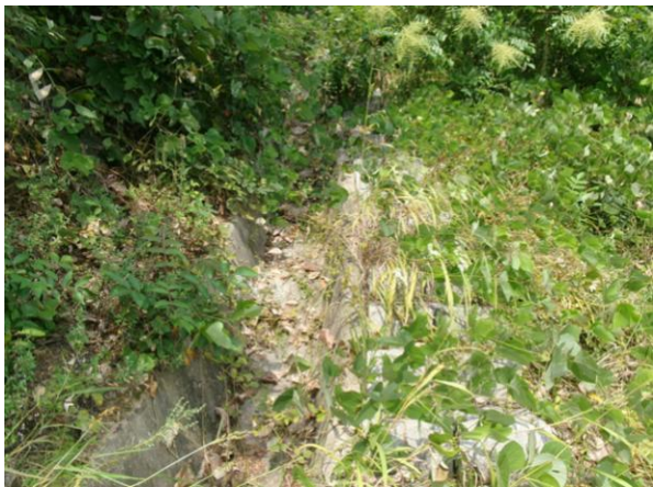
산마루측구, 점검계단 전경
