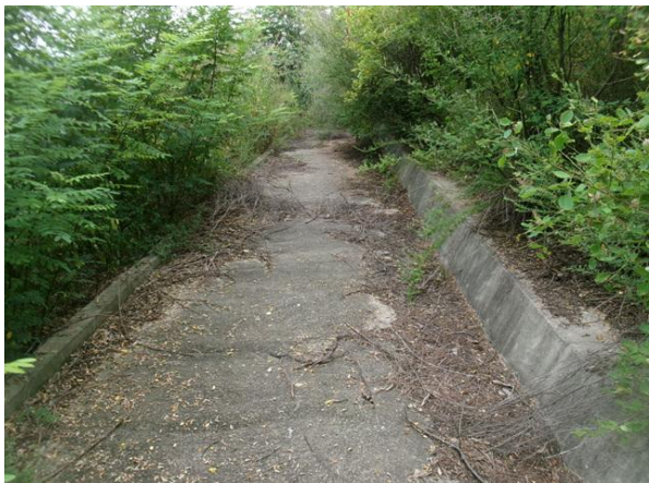
1소단 배수로 전경
