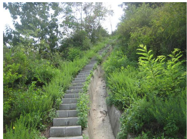
점검계단, 산마루측구 전경
