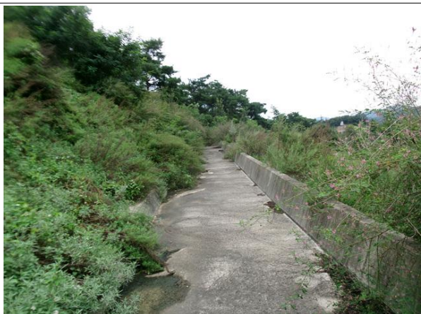
1소단 배수로 전경
