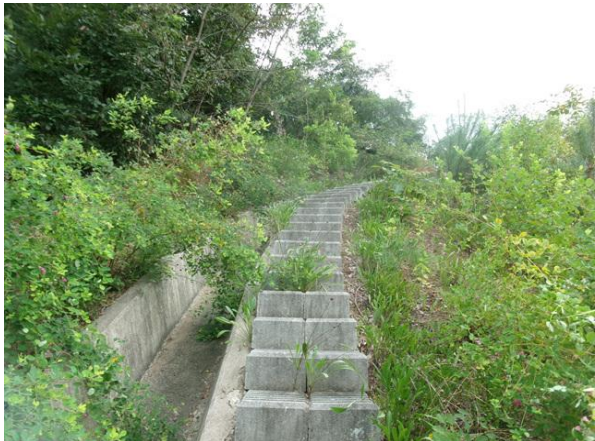
산마루측구, 점검계단 전경
