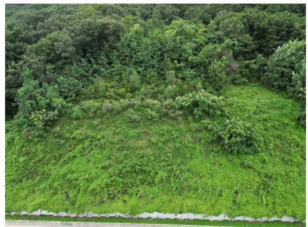
사면부, 하단 판넬형옹벽 전경
