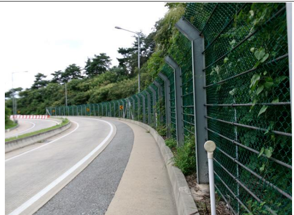
도로, 낙석방지울타리 전경
