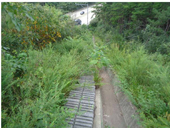
산마루측구, 점검계단 전경
