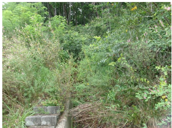
산마루측구, 점검계단 전경
