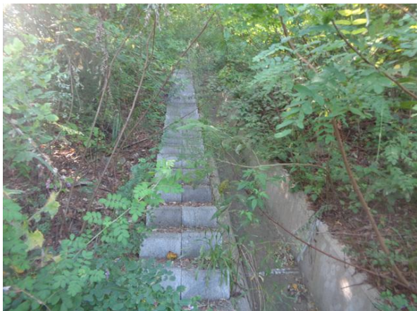
산마루측구, 점검계단 전경
