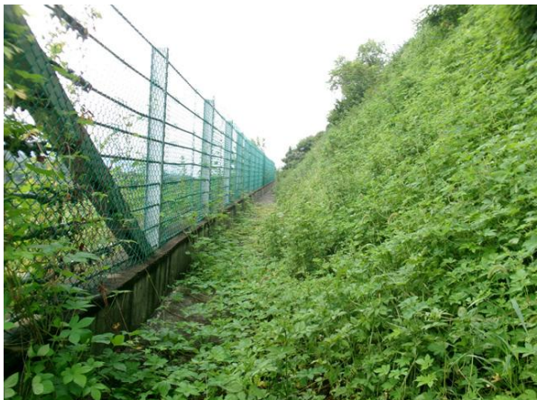
1소단 배수로 전경
