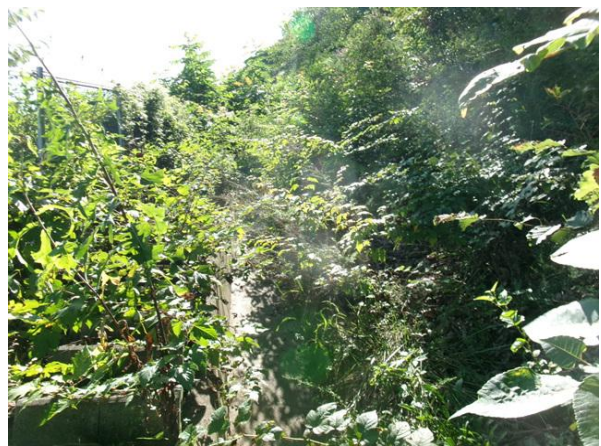
산마루측구, 점검계단 전경
