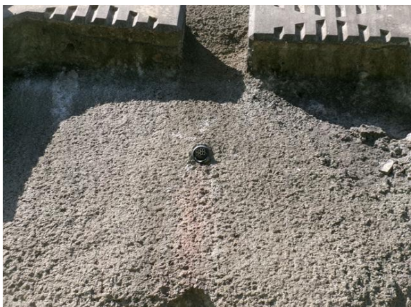
앵커부 수평배수공 전경
