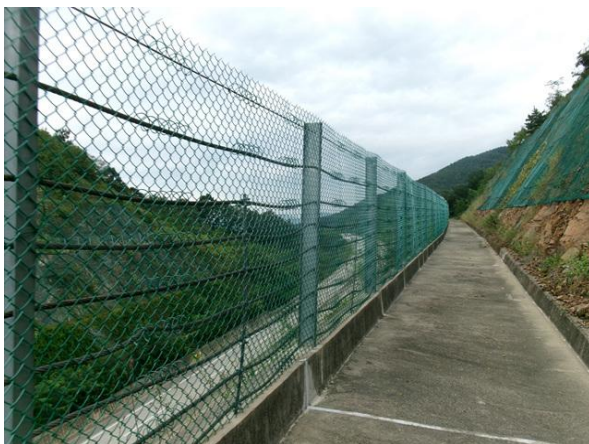
소단배수로 낙석방지울타리 전경
