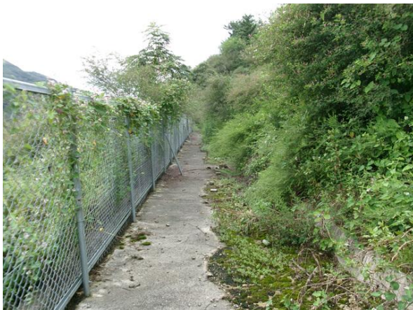
1소단 배수로 전경
