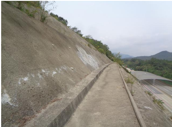
1소단 배수로 전경
