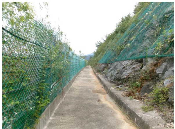
소단배수로 낙석방지울타리 전경
