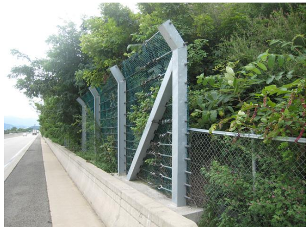
하단 낙석방지울타리 전경
