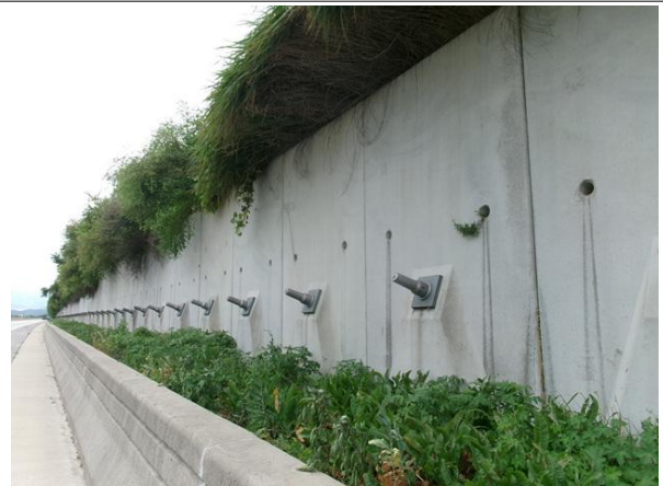
사면내 옹벽 전경
