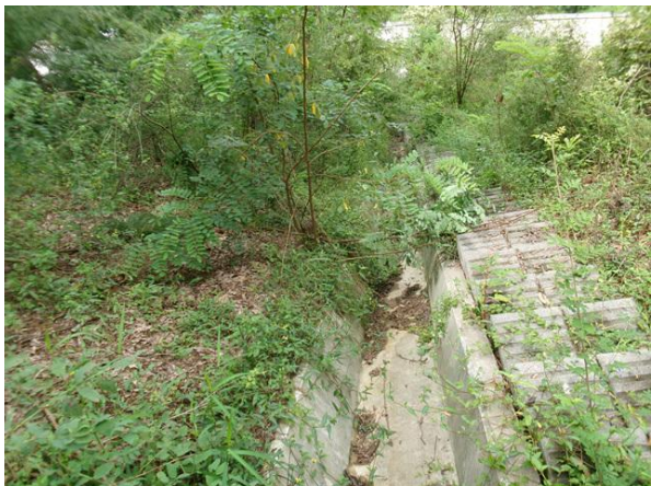
점검계단, 산마루측구 전경
