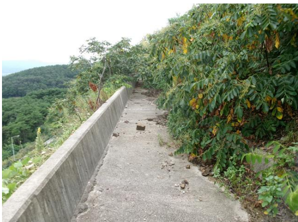
2소단 배수로 전경
