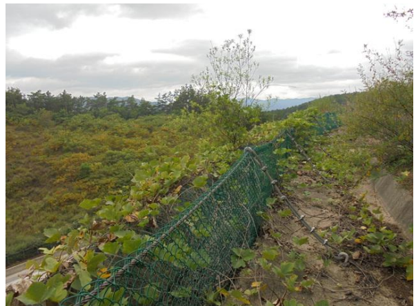
1소단 배수로 전경
