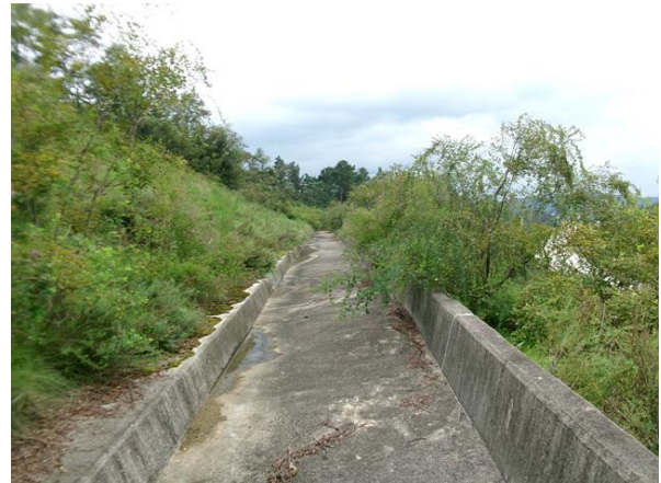
1소단 배수로 전경
