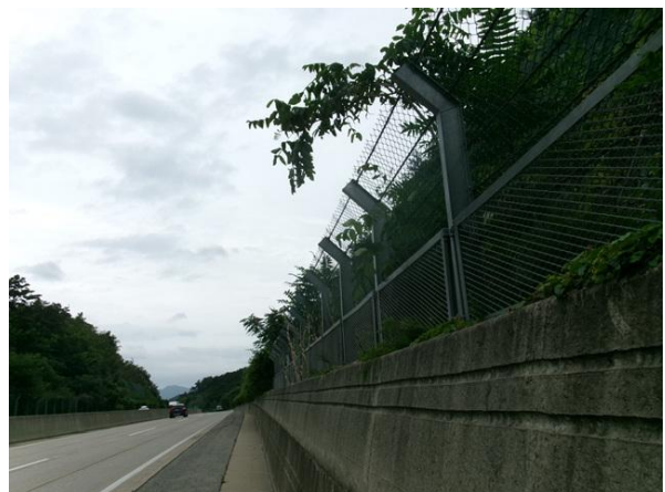
도로, 낙석방지울타리 전경
