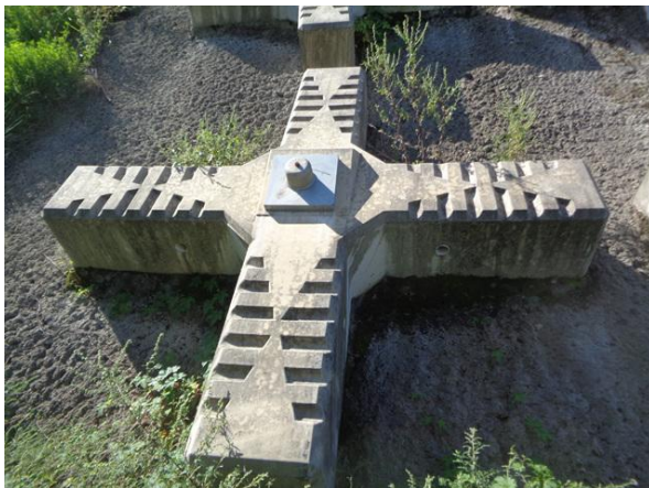
-shot크리트, 격자앵커 전경
