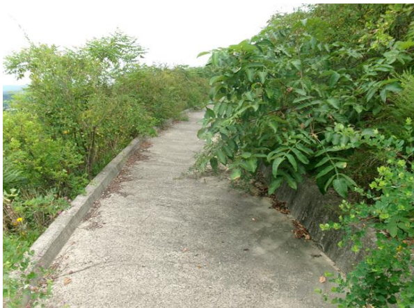
1소단 배수로 전경
