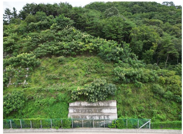
사면내 옹벽 전경
