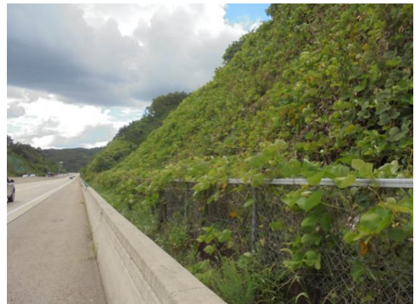
도로, 야생동물유도울타리 전경
