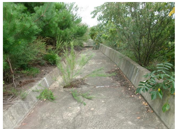
1소단 배수로 전경
