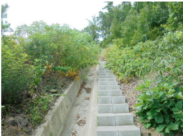
점검계단, 산마루측구 전경
