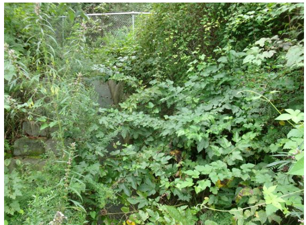
산마루측구, 점검계단 전경
