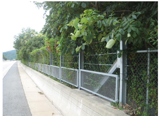
하단, 낙석방지울타리 전경
