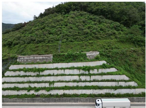
사면내 옹벽 전경
